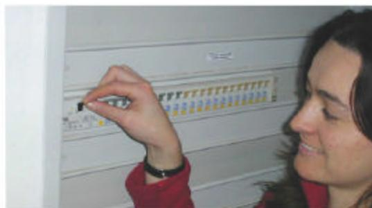
Alle Fehlerstromschutzschalter sind mit einer Prüftaste ausgestattet, die einen Funktionstest erlaubt. Wird die Prüfung nicht durchgeführt, können die Kontakte verkleben. Ein Auslösen im Fehlerfall ist dann nicht möglich.
